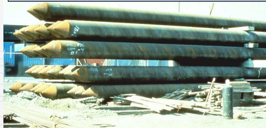
شمع‌های لوله‌ای ته‌بسته با غلاف نوک تیز انتهایی
